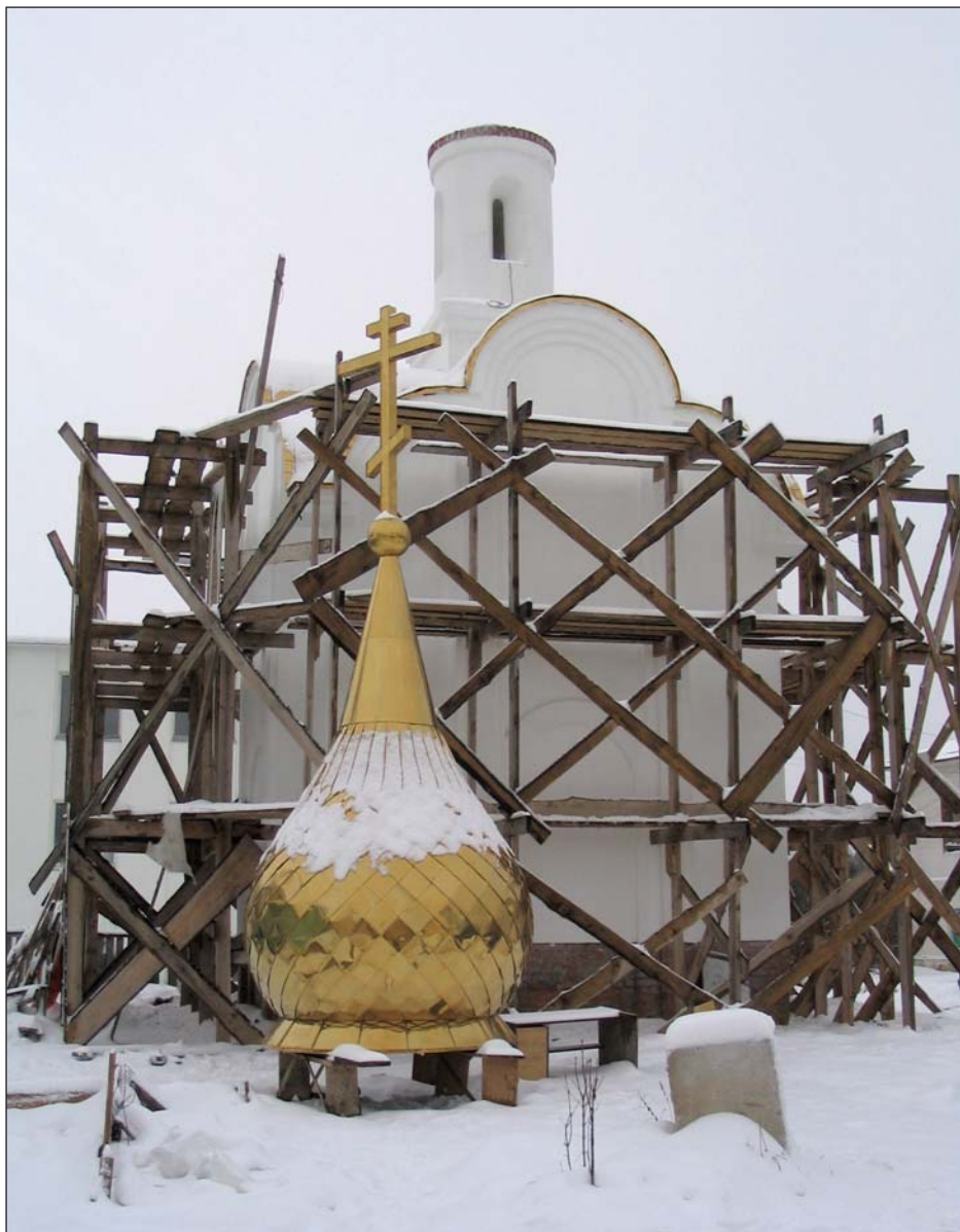
Подъём и установка креста и купола. 3 декабря 2004 г.
