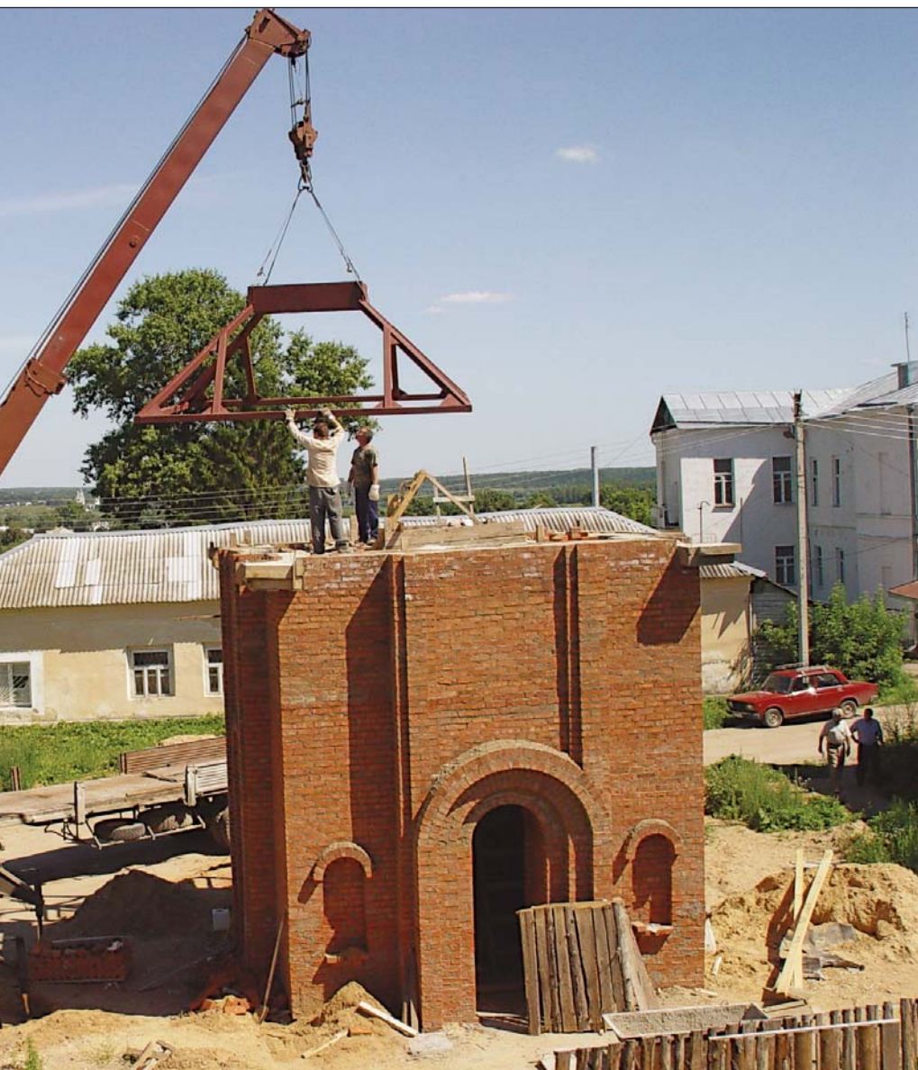
Этап строительства часовни. 23 июля 2003 г. Фото А. Денисова
