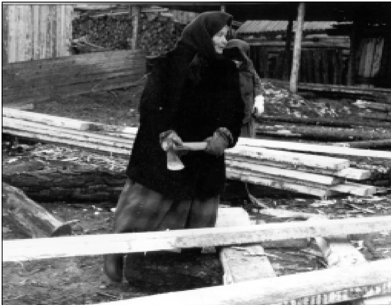
Верующие на строительстве часовни при молельном доме. Фото В.И.Осташова.
