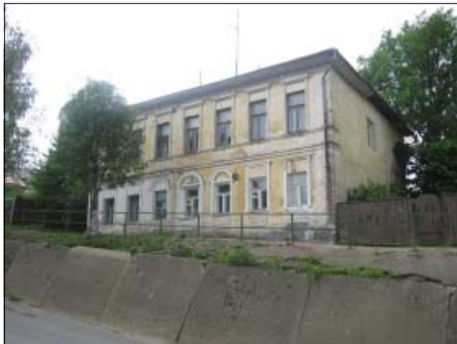
В этом здании находилось училище, где преподавал К.Э. Циолковский. (Ныне ул. Урицкого, д.21).
