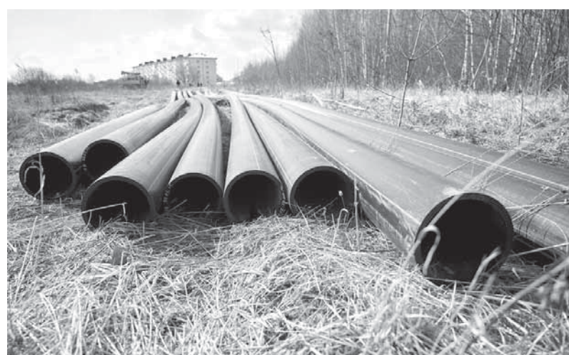
Областной «Водоканал» прокладывает водовод
