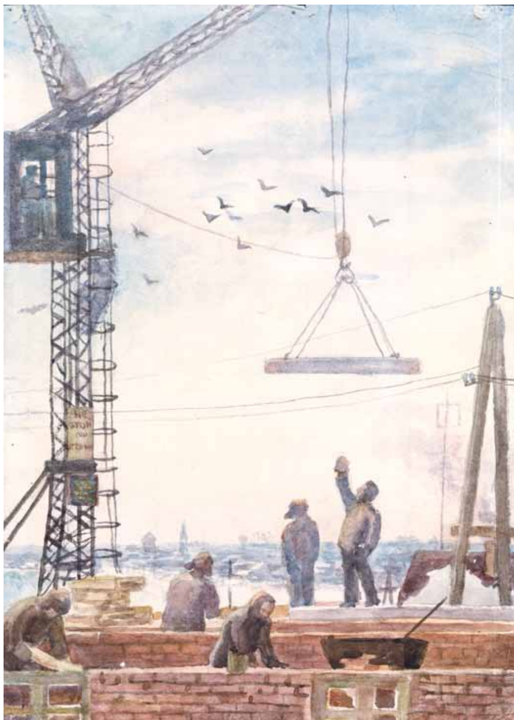
Стройка. Из моего окна
