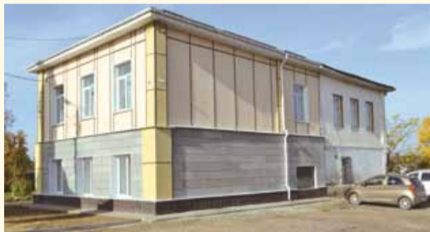
Искажение облика исторического здания на Советской, 6а
