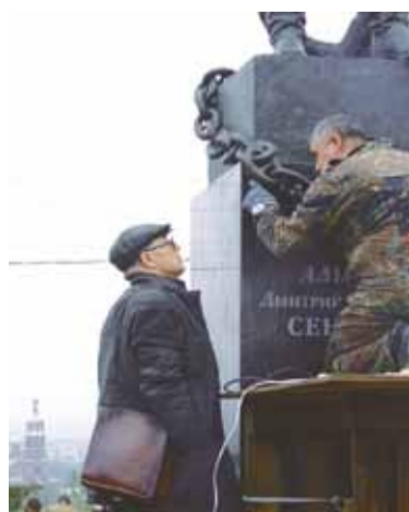
М. Переяславец контролирует монтаж памятника адмиралу Сенявину в Боровске. 2014 г.
